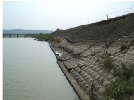
a)河床低下による護岸崩壊
