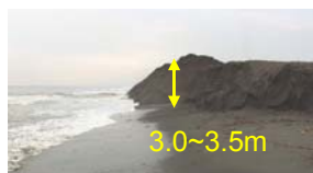
【養浜状況: 石崎浜】 波打際付近までの砂の押し出し 3.0～3.5m
