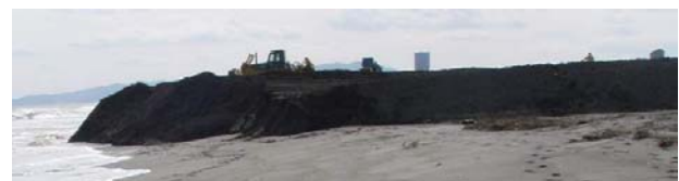
ブルドーザーによる土砂押し出し
