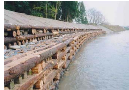
写真－ 3.1 木材を利用した侵食防止装置の例
