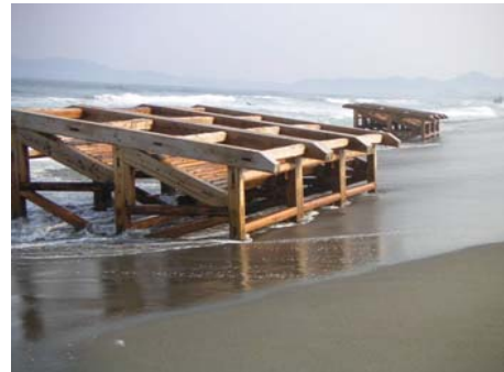
写真－ 3.1 木材を利用した侵食防止装置の例
