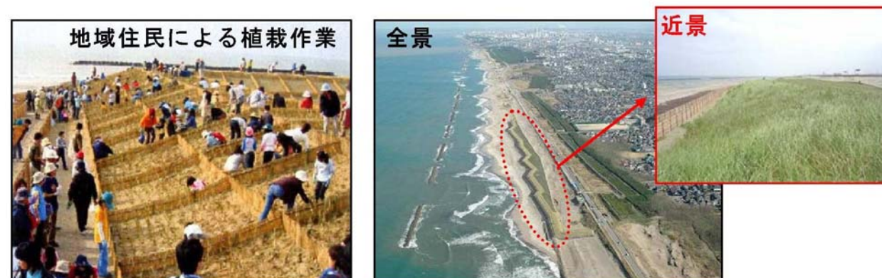
写真－ 3.2 木材の利用や、植栽による斜面防護の例
