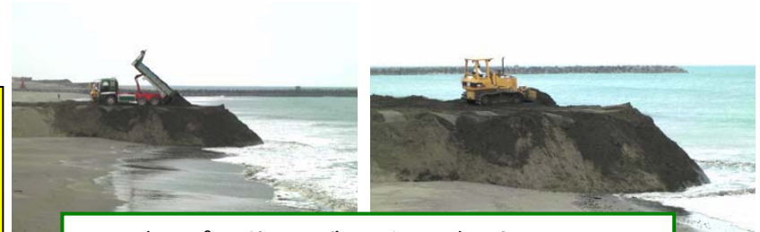
ダンプ運搬+ブルドーザで押し出し
