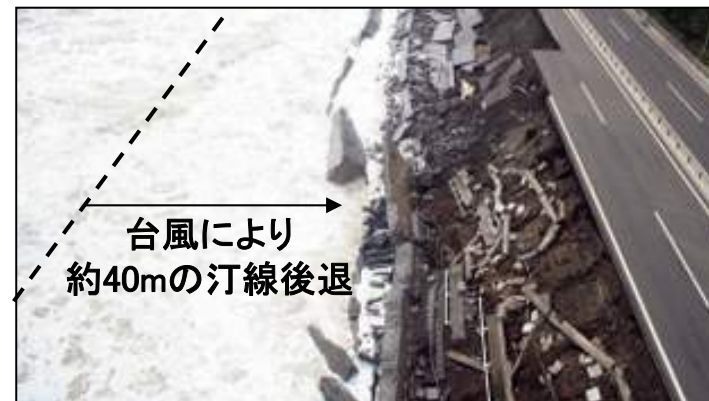
＜沿岸道路の被災事例＞ 神奈川県西湘バイパス(平成19年8月29日)
