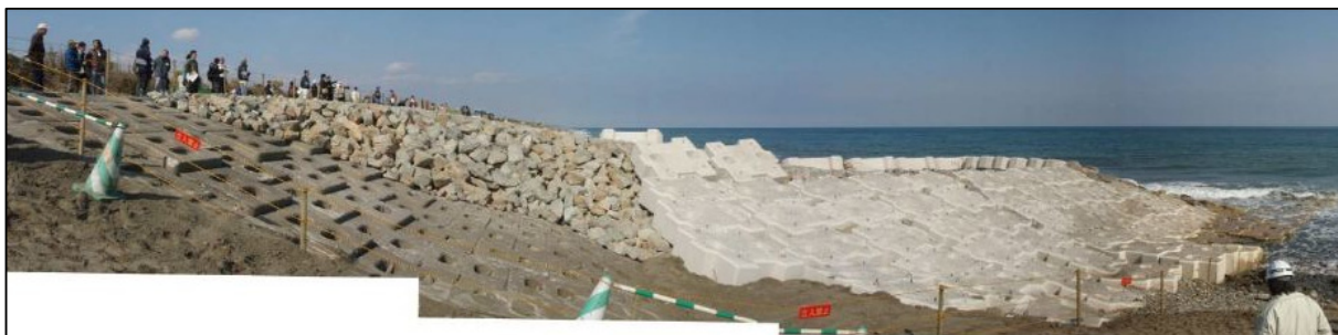
写真－4 突堤現地見学会の様子
