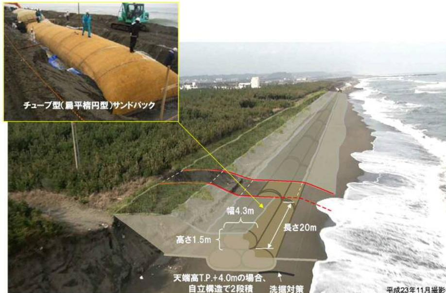
サンドバック工法を適用した埋設護岸の整備イメージ(大炊田地区北側の鳥瞰)
