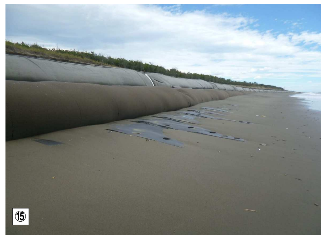
写真－ 1.24 アスファルトマットの状況（めくれなし，平成 26 年 8 月 10 日）
