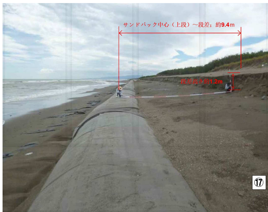
写真ー 1.26 サンドバック背後の養浜の段差（平成 26 年 8 月 10 日）
