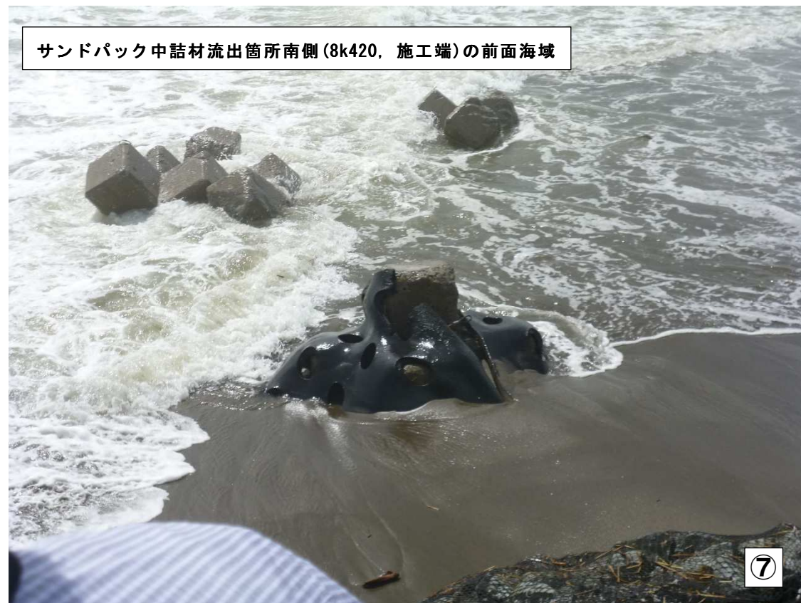
写真－ 1.3 アスファルトマットの変形状況（平成 26 年 8 月 7 日）
