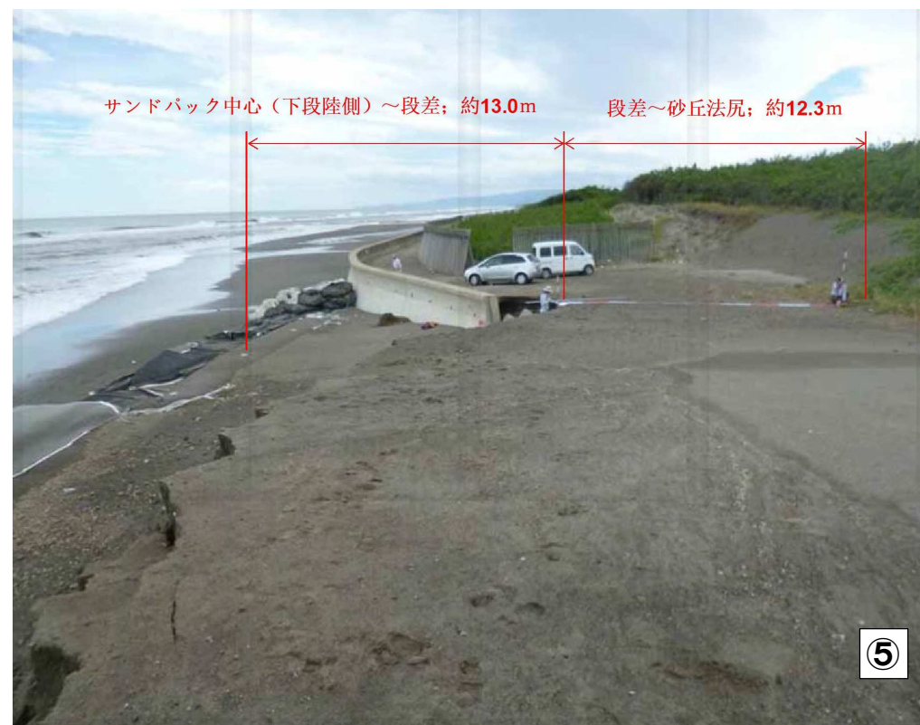
写真ー 1.14 南端のサンドバック背後の養浜の段差（平成 26 年 8 月 10 日）
