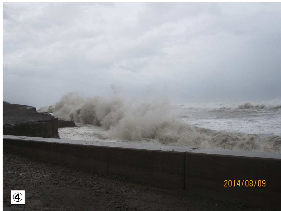
写真ー 1.8 サンドパックの越波状況（平成 26 年 8 月 9 日）
