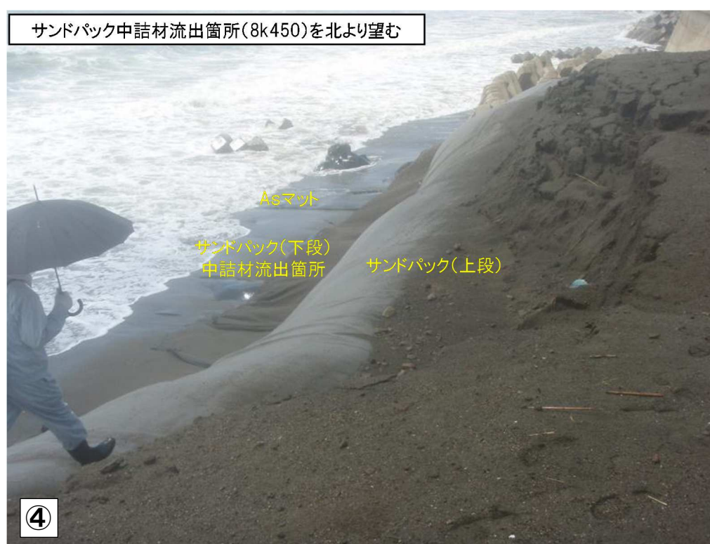
写真ー 1.1(2) サンドバック中詰材流出状況（平成 26 年 8 月 7 日）
