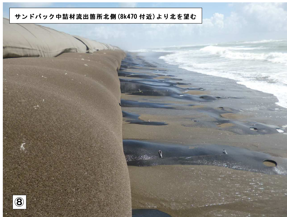
写真－ 1.4 アスファルトマットの露出状況（平成 26 年 8 月 7 日）
