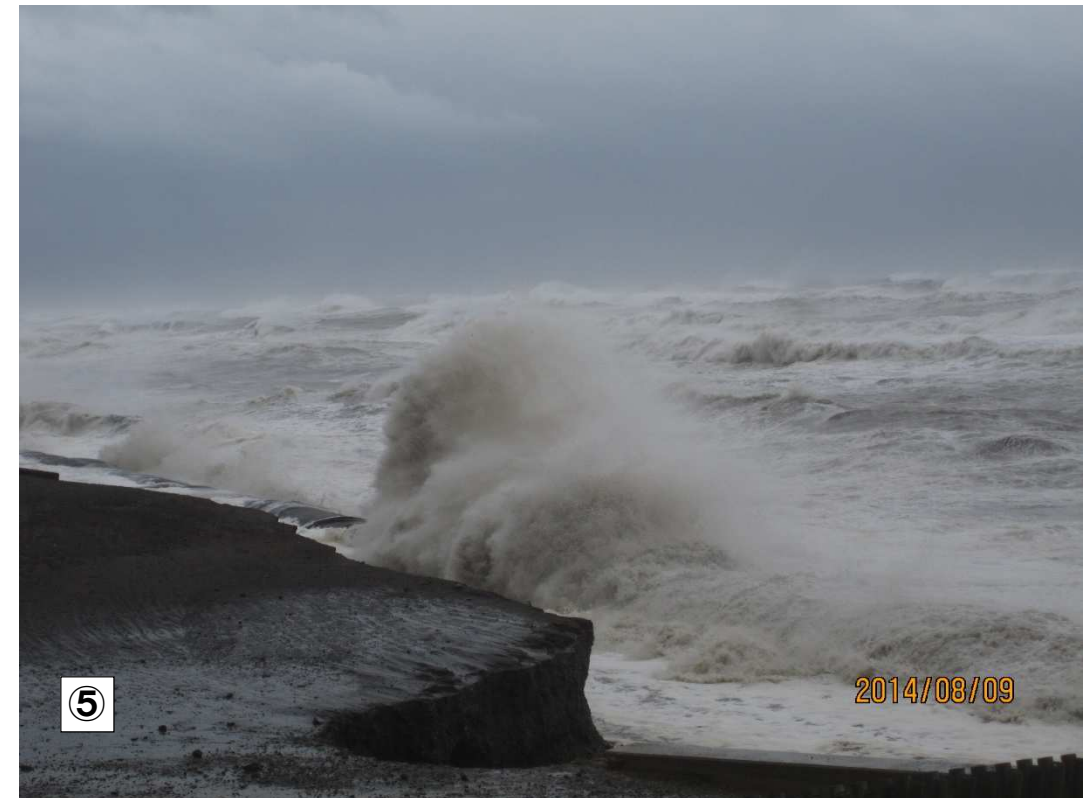
写真ー 1.9 サンドパックの越波状況（平成 26 年 8 月 9 日）
