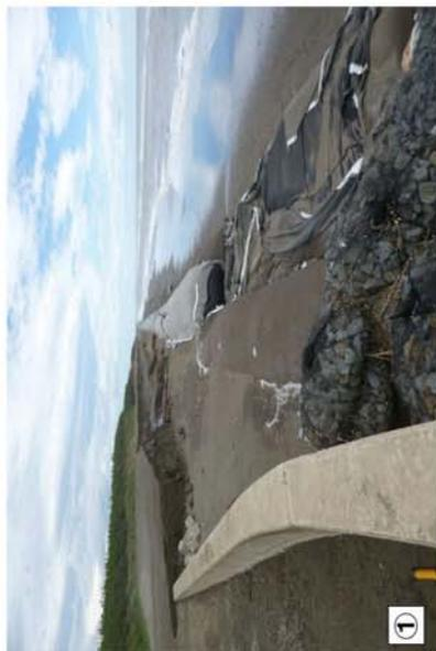
写真-1.10 南端のサンドバットの変状(変状箇所A、平成26年8月10日)
