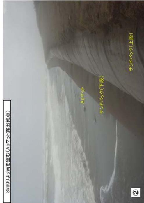
写真-1.6 サンドバックの露出状況(平成26年8月8日)
