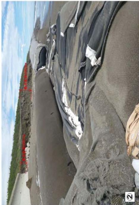
写真-1.11 南端のサンドバットの変状(変状箇所A、平成26年8月10日)
