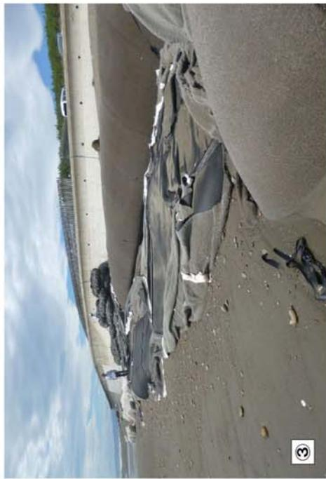
写真-1.12 南端のサンドバットの変状(変状箇所A、平成26年8月10日)
