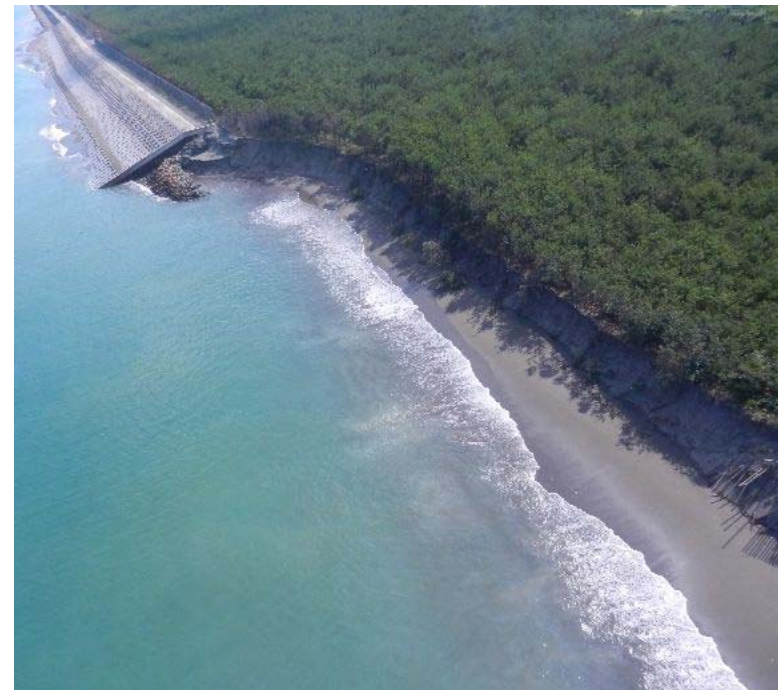
② 石崎浜Co護岸端部 (H27.7.28)
