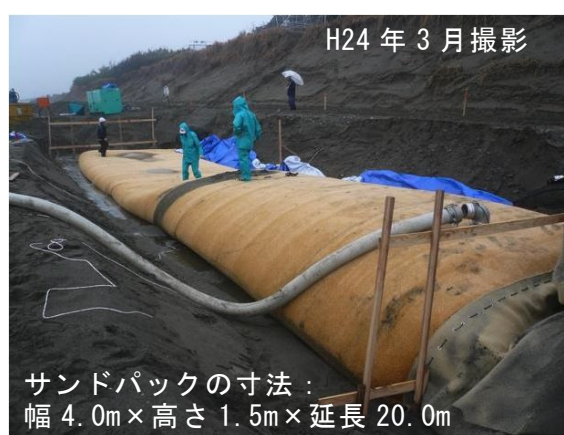
施工状況（サンドパック袋材への砂の充填の様子）
