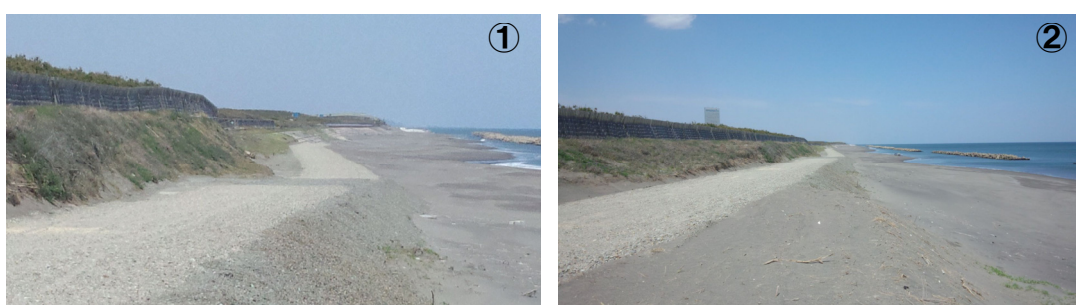
施工後(平成25年4月撮影)
