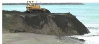
ブルドーザ押土イメージ
