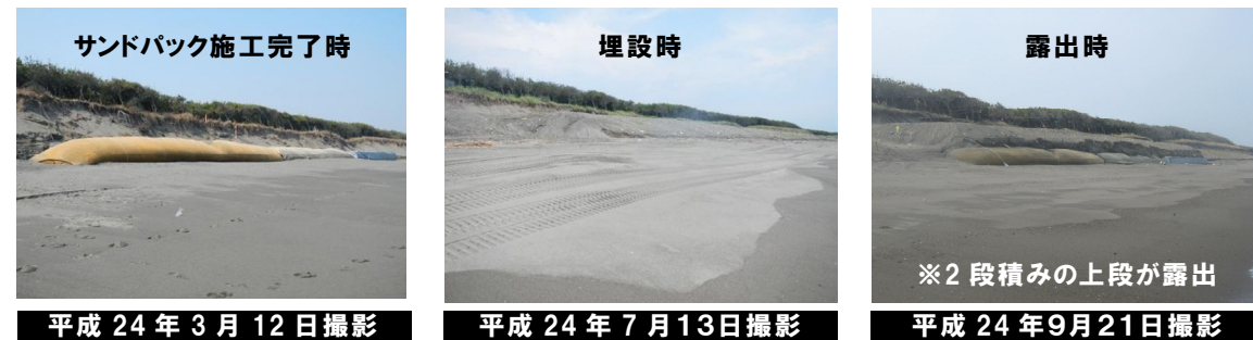
写真 6.2 試験施工時の埋設護岸の整備の状況
