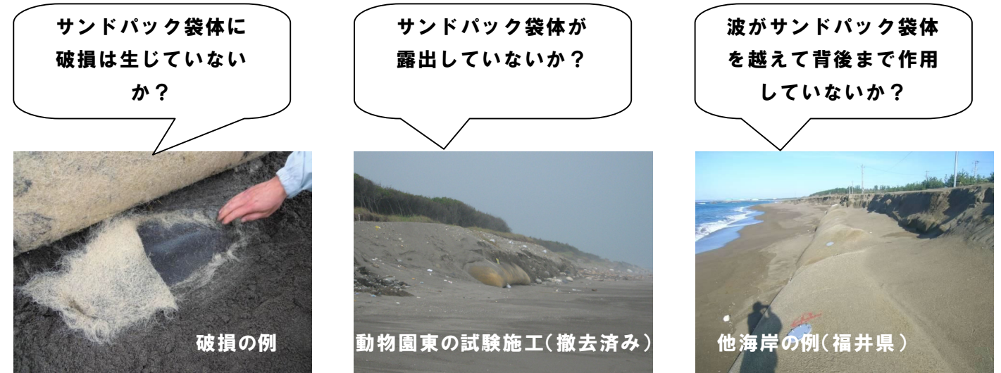
図ー 6.5 埋設護岸における目視点検のイメージ
