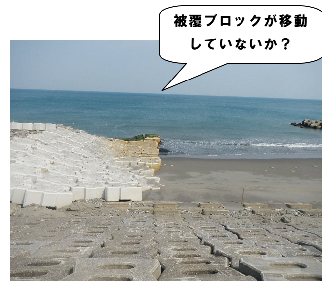
図－ 6.2 突堤における目視点検のイメージ
