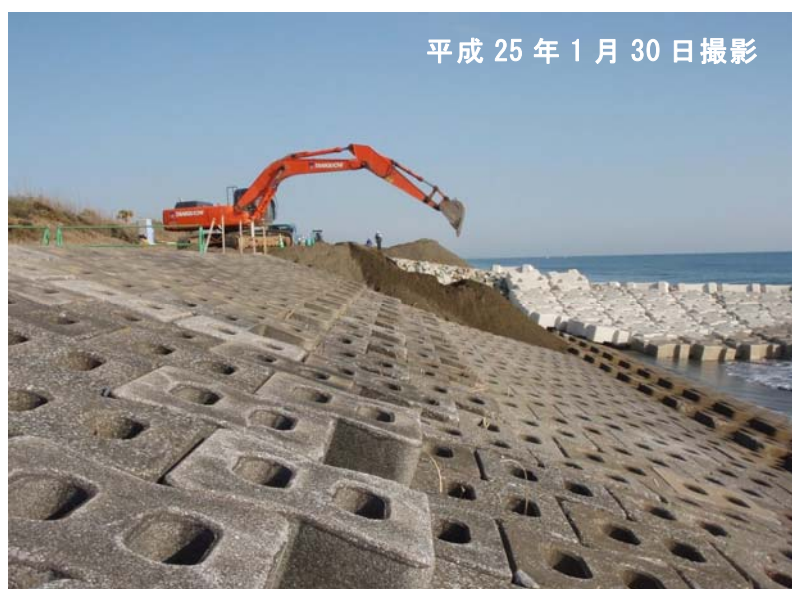
実施箇所状況
