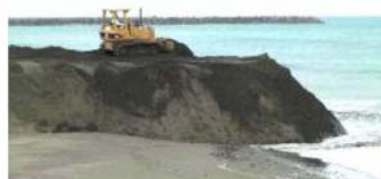
ブルドーザ押土イメージ
