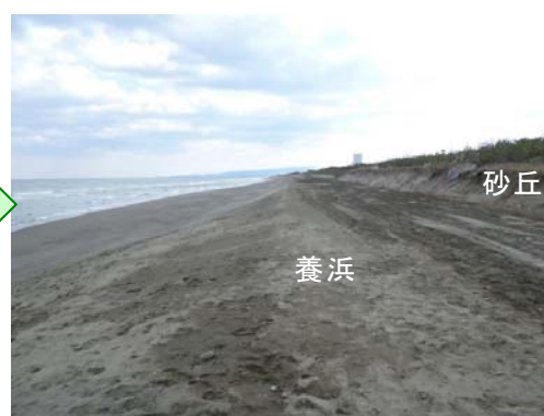
H26. 3. 21 撮影（養浜工事完了）
