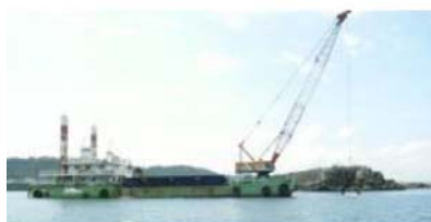
航路浚渫イメージ
