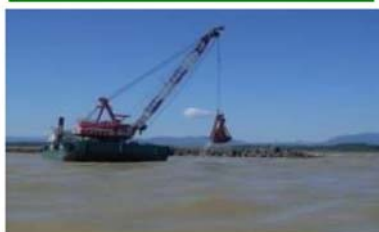
航路浚渫イメージ
