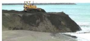
ブルドーザ押土イメージ
