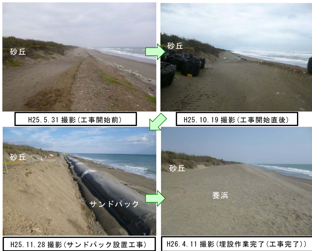
実施箇所状況
