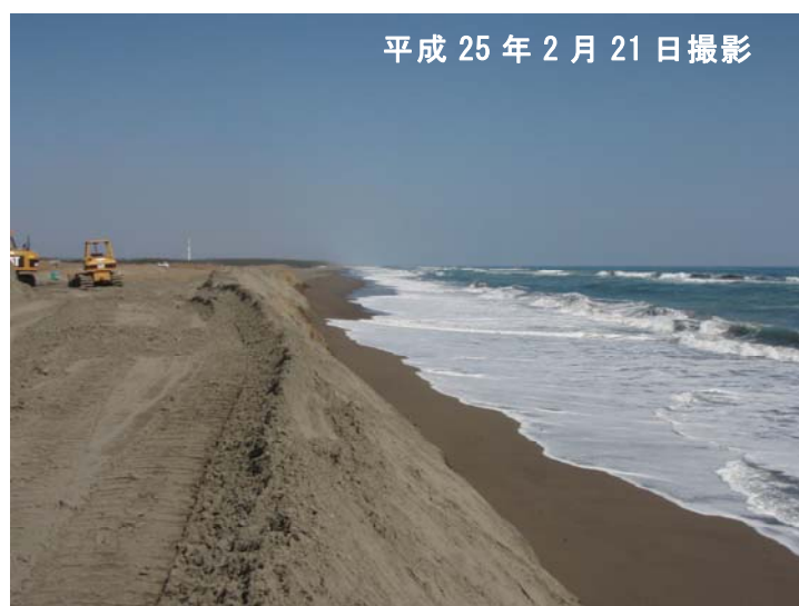
実施箇所状況
