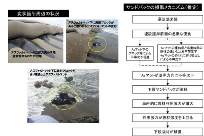
図－ 1.3 サンドバックの損傷メカニズムの推定（第9回技術分科会資料より）
