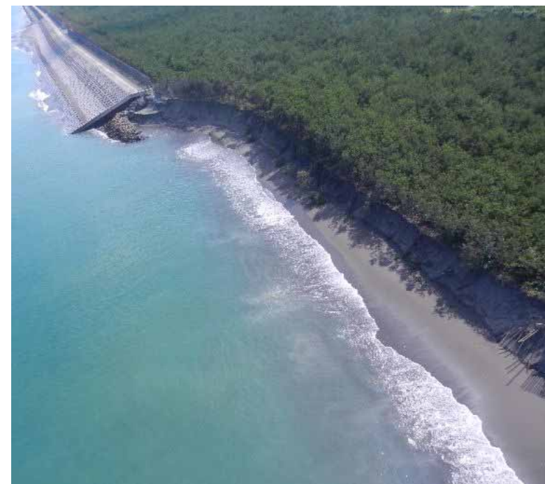
②石崎浜Co護岸端部 (H27.7.28)
