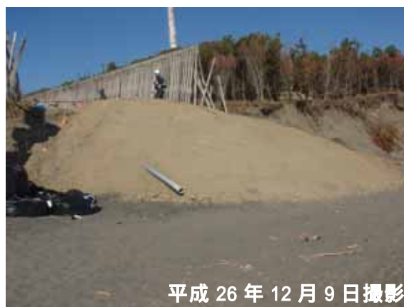
実施箇所状況
