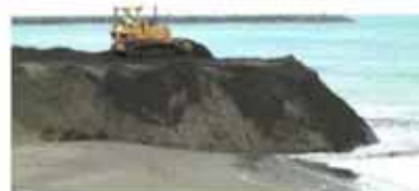
ブルドーザ押土イメージ
