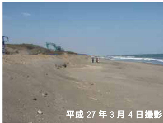
実施箇所状況
