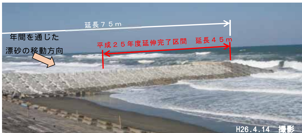
工事位置図および実施箇所状況
