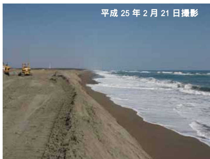
実施箇所状況
