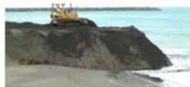
ブルドーザ押土イメージ
