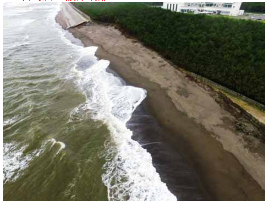
石崎浜Co護岸端部
