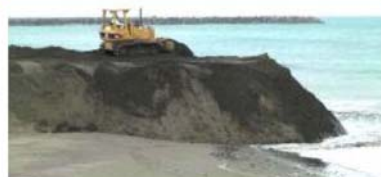
ブルドーザ押土イメージ
