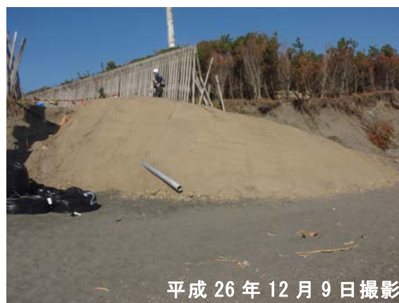
実施箇所状況
