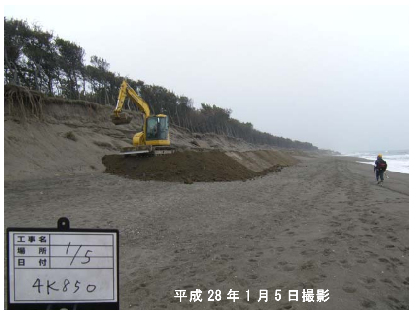
実施箇所状況
