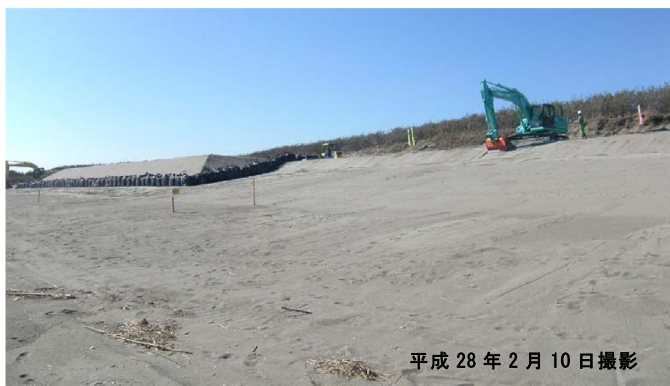
実施箇所状況
