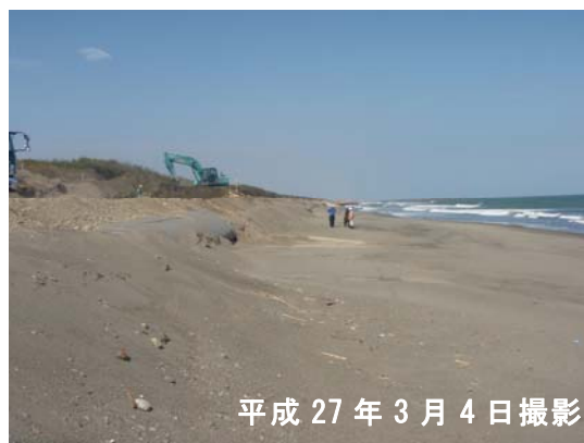
実施箇所状況
