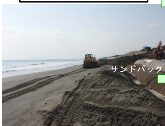
H27.2.18 撮影(サンドパック設置工事)
