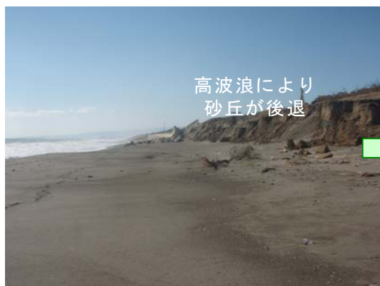
H26.11.4 撮影(工事開始前)
