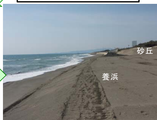
H27.3.25 撮影(埋設作業完了(工事完了))
