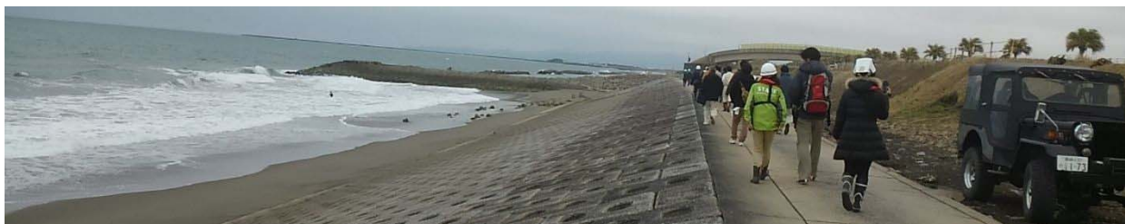
図－ 3.5 突堤北側の堆砂状況 (2016 (H28) 年 1 月 30 日撮影)
