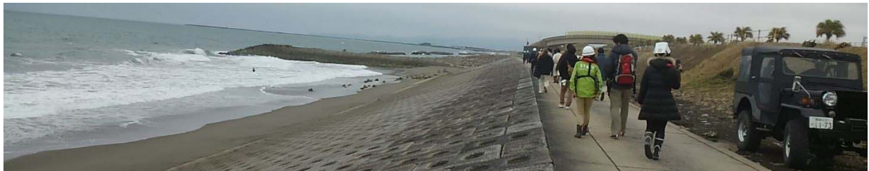
図-8 突堤北側の堆砂状況 (2016 (H28) 年 1 月 30 日撮影)
