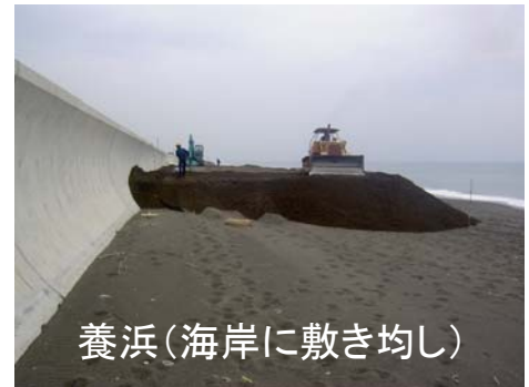
河川掘削土砂の運搬
