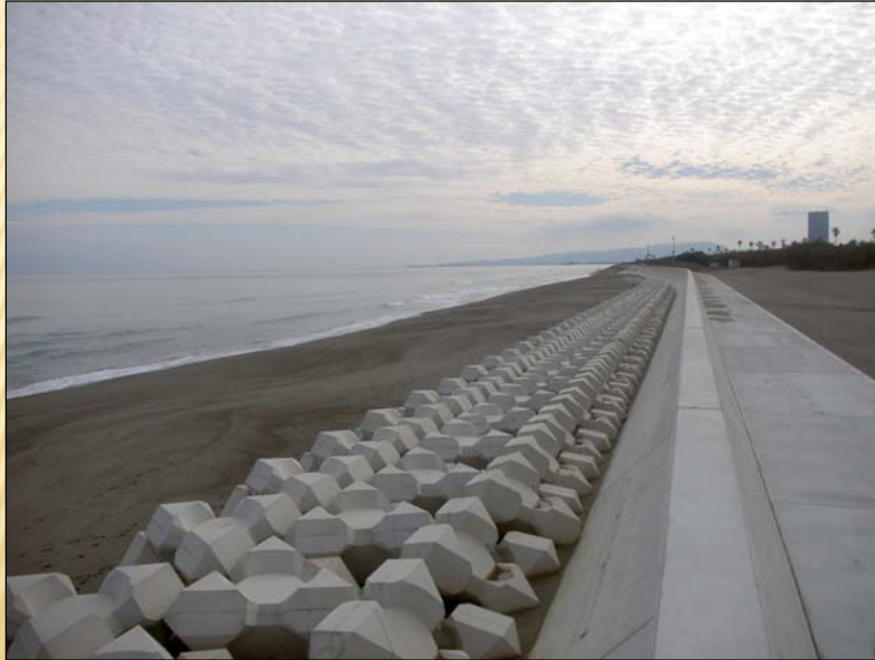
林務部施工(傾斜護岸) 災害復旧(保安林保全)
