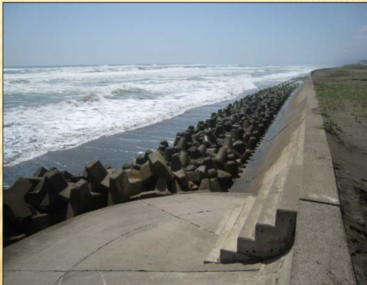
農政水産部施工(傾斜護岸) 農地海岸保全
