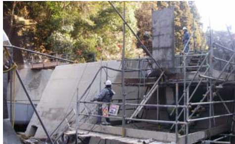
蒲牟田第1砂防えん堤透過型化工事(H22.1時点)
