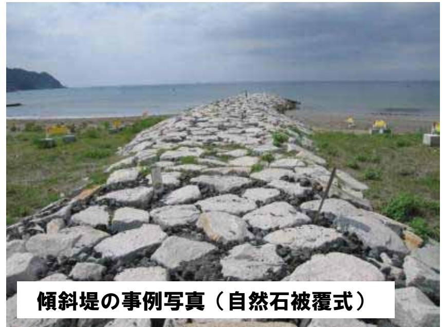
傾斜堤の事例写真（自然石被覆式）
