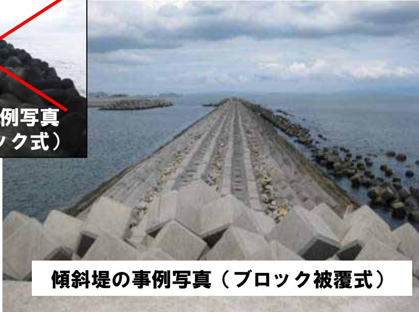
傾斜堤の事例写真（ブロック被覆式）
