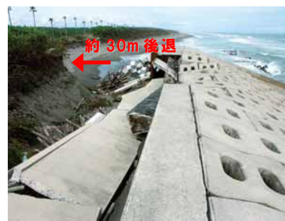
大炊田海岸 平成23年(2011年)【台風6号,12号,15号通過後の浜崖後退】
