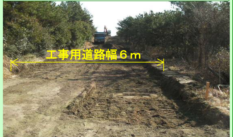
工事用道路設置（アスファルト舗装）のため掘削作業中（H24. 1. 18撮影）
