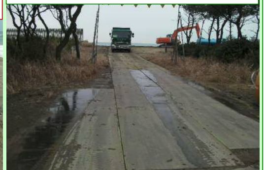
工事用道路設置完了 （H24. 2. 10撮影）
