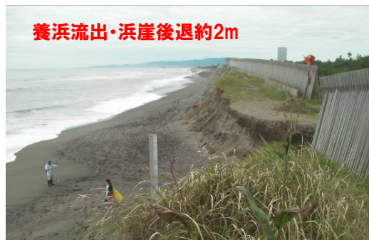
【台風12号後】平成23年9月4日撮影
