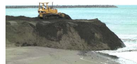
ブルドーザ押土イメージ
