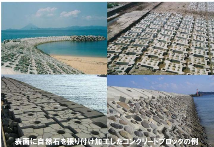
表面に自然石を張り付け加工したコンクリートブロックの例
