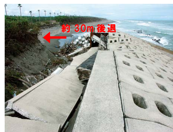
大炊田海岸 平成23年【台風6号,12号,15号通過後の浜崖位置の変化】
