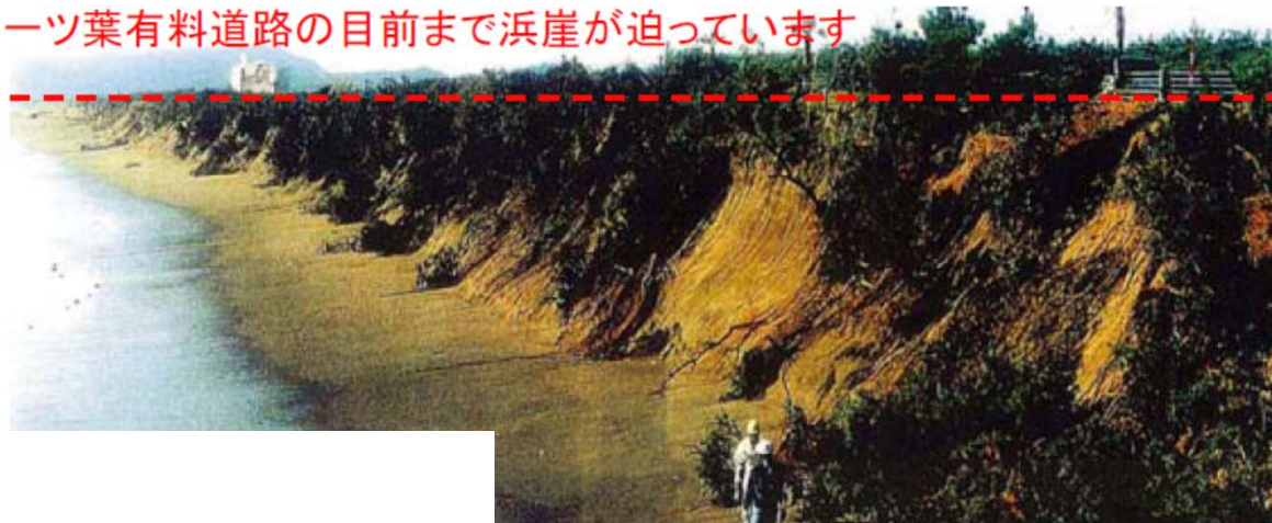
シーガイアIC南側自然海岸被災状況 <平成10(1998)年>
