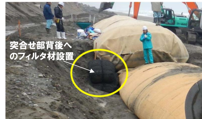
突合せ部背後の砂の吸出し防止対策
