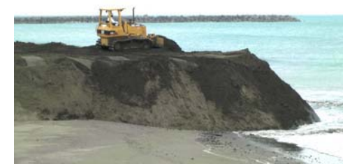
ブルドーザ押土イメージ
