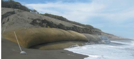
埋設護岸による安全性の確保
