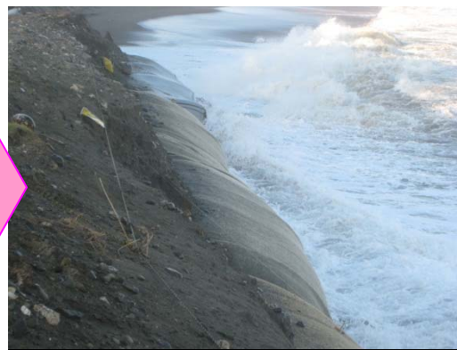
サンドパックが露出し波が直接当たる (平成24年10月13日撮影)
