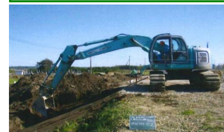
ブルドーザ押土イメージ
