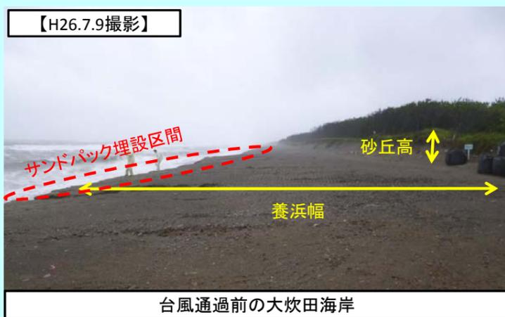
サンドバック背面の砂丘高、養浜幅ともに台風前のまま!!
