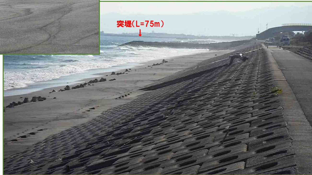
■レストハウス前面の堤防上より
