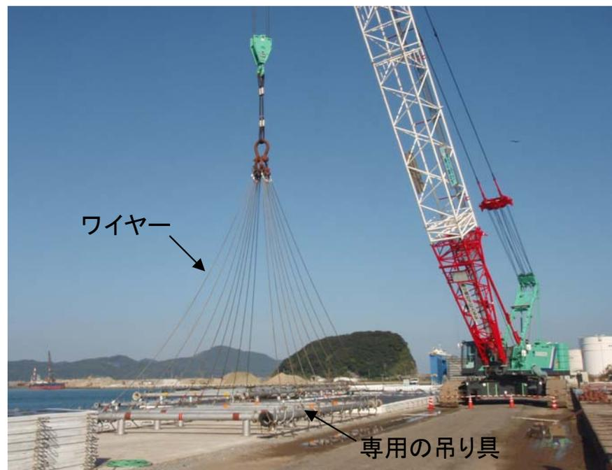
アスファルトマットを専用の吊り具に固定し、ワイヤーを介してクレーンで吊り上げ、現地に設置。
