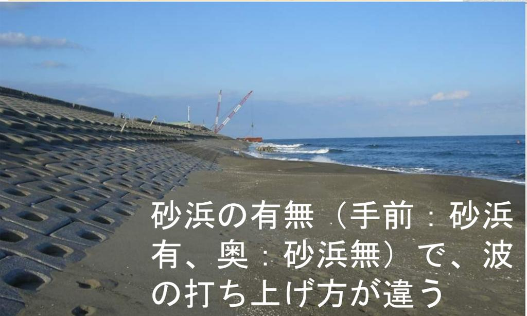
砂浜の有無（手前：砂浜有、奥：砂浜無）で、波の打ち上げ方が違う
