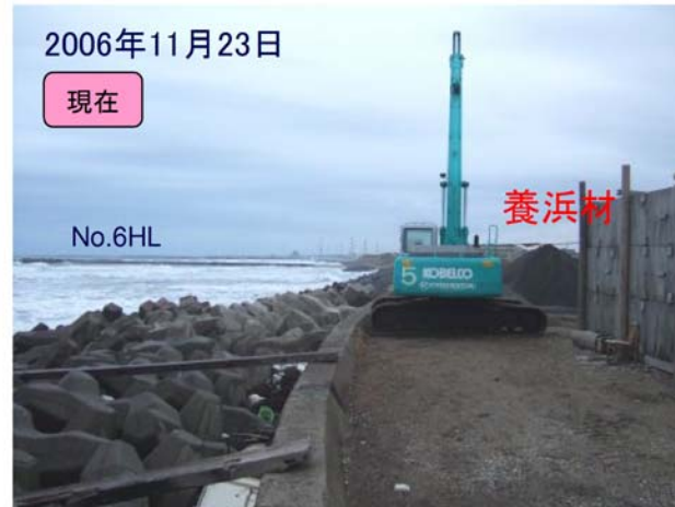
バックホウによる直接投入
