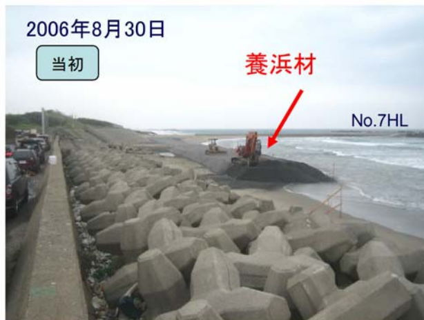
計画断面(盛土)による施工
