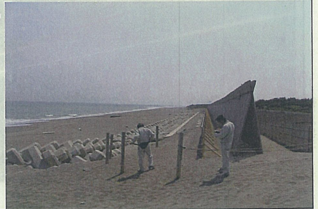
平成16年度に災害復旧により実施した箇所 (傾斜堤+消波工+防風垣+マツ植栽)
