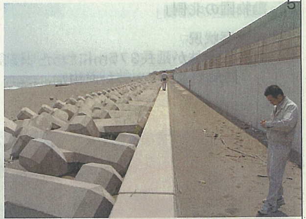
平成16年度に災害復旧により実施した箇所 (傾斜堤+消波工+防風垣+マツ植栽)
