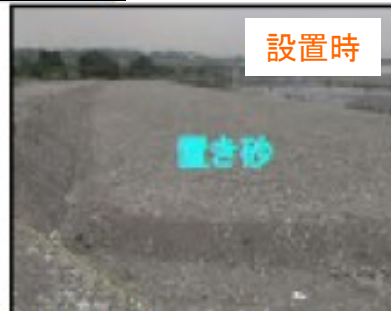
置き砂設置時(上流を望む①)
