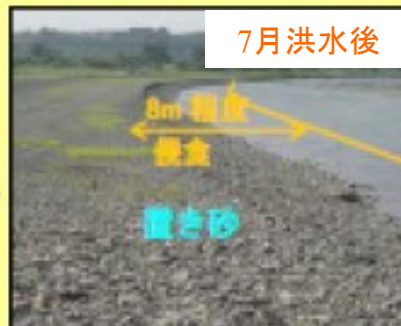
洪水後の流出状況(上流を望む④)
