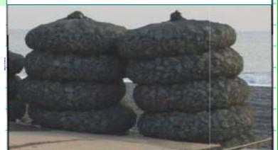
袋詰石：こぶし大の石をネットに詰めたもの。主に洗掘（流水で土砂が削り取られる現象）対策として用いられる。
