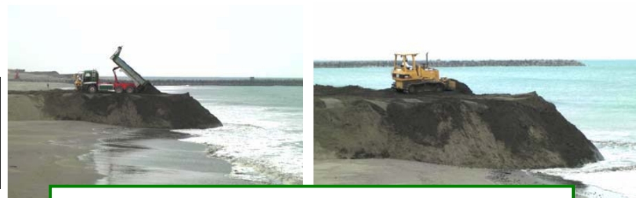
ダンプ運搬+ブルドーザで押し出し
