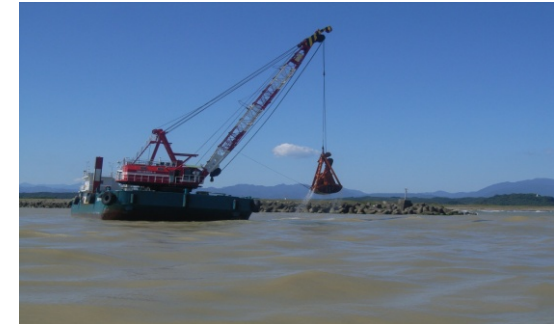
航路浚渫イメージ
