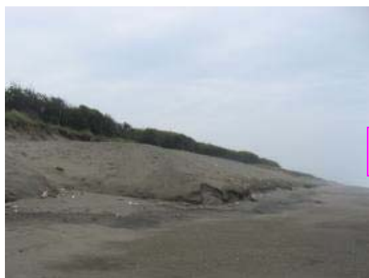
サンドバック埋設状況 (平成24年5月24日撮影)
