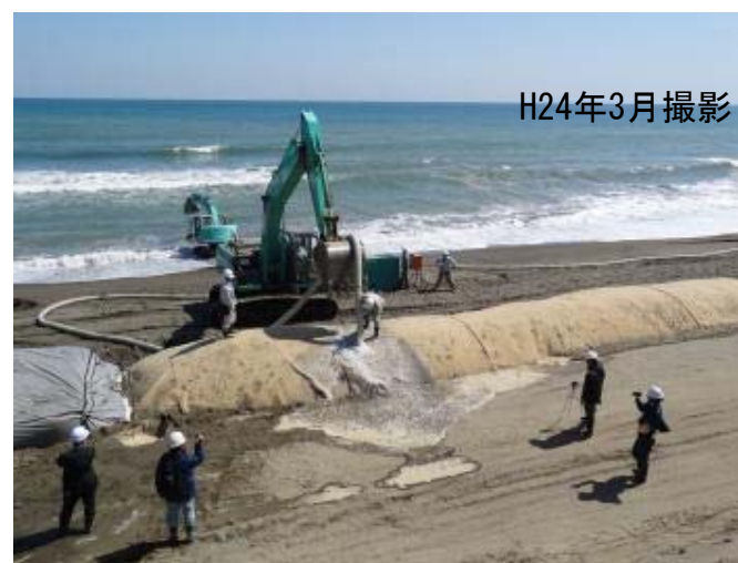
高波時に越波した際の土砂の吸い出し を模擬越波実験で確認(吸い出しなし)
