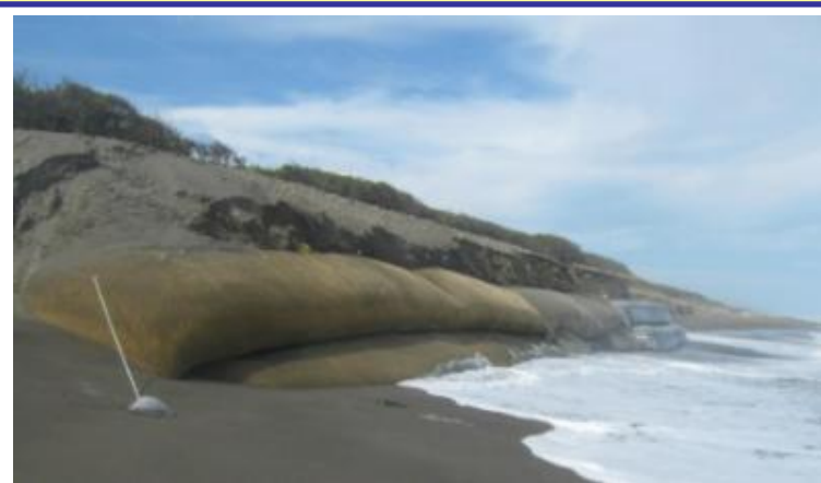
浜崖後退抑止工(サンドバック)※
