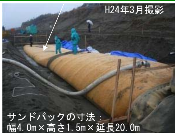
施工状況 (サンドバック袋材への砂の充填の様子)
