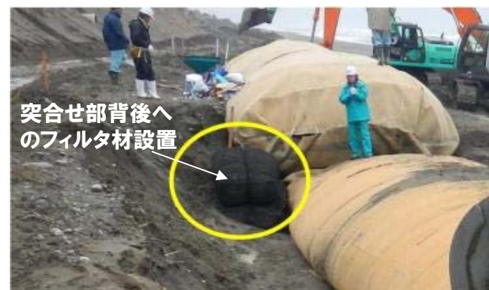
突合せ部背後の砂の吸出し防止対策
