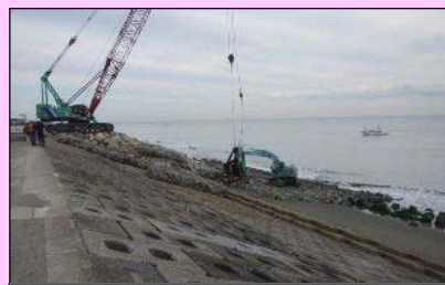
突堤建設工事 (H24. 12. 11現在)
