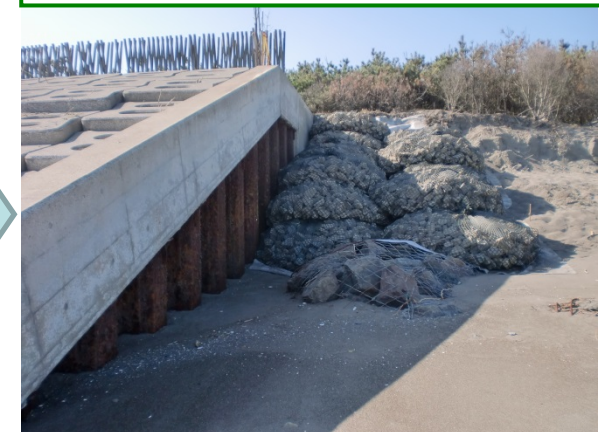
袋詰玉石設置状況(H26.10)
