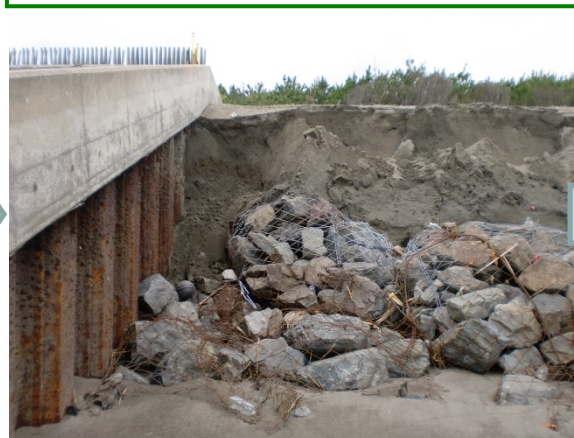
護岸端部露出状況(H26.7)
