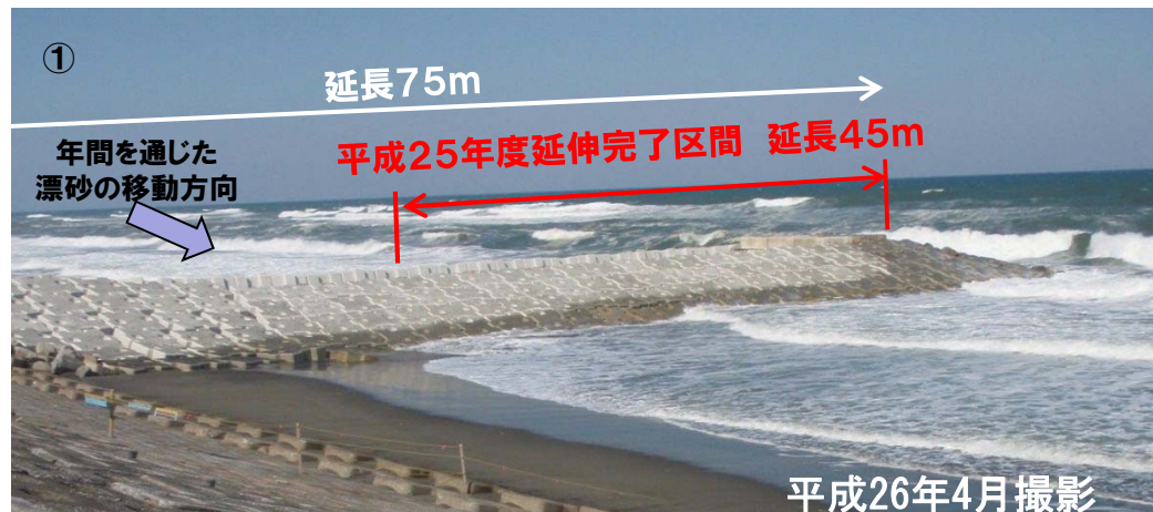
平成25年度施工
