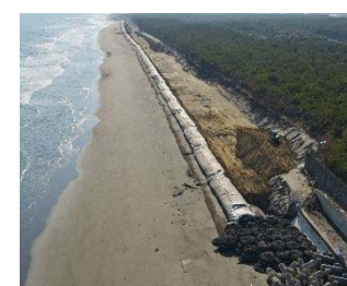
養浜覆土前の状況(北端部)
