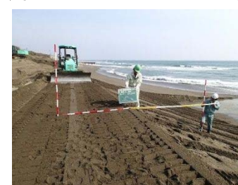
養浜によりサンドバックを埋設
