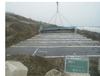
アスファルトマット敷設
