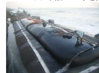
サンドバック中詰めめの砂を充填
