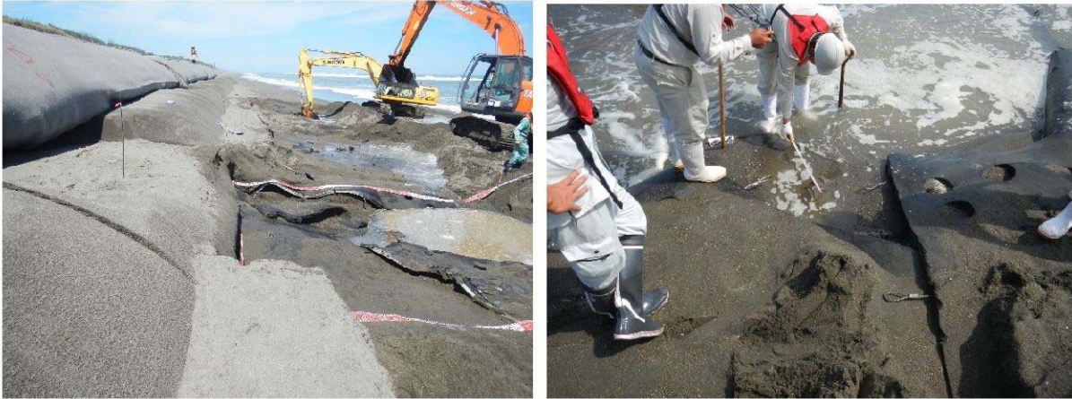
アスファルトマット敷高計測
