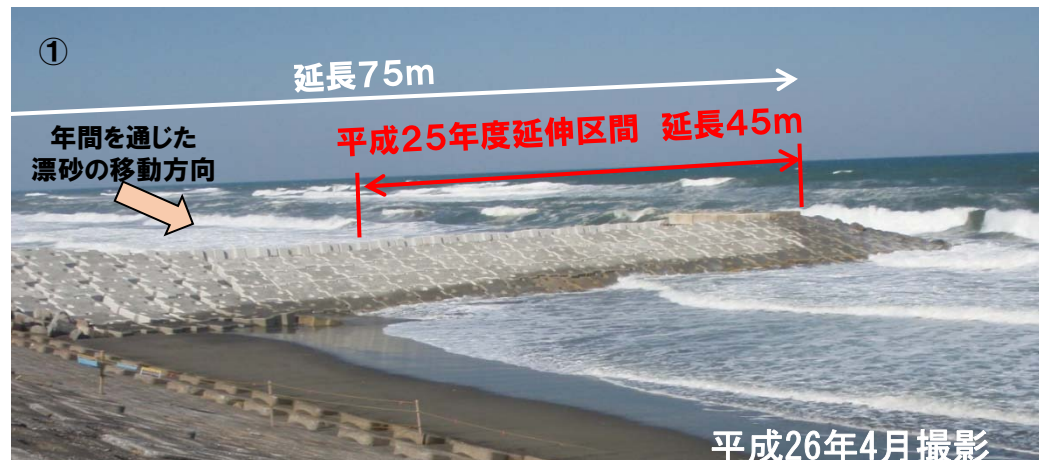
平成25年度施工
