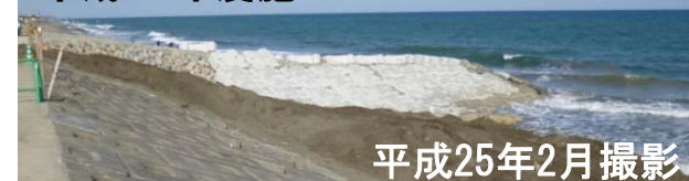
平成24年度施工
