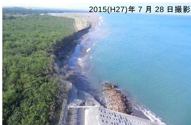
写真 石崎浜侵食状況
