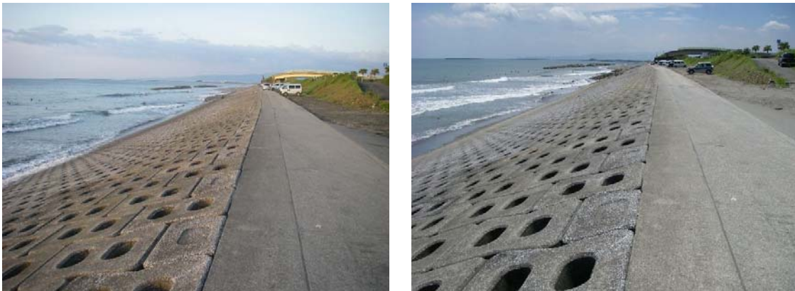
図－ 4.41 突堤設置前写真（平成 22 年 7 月）
