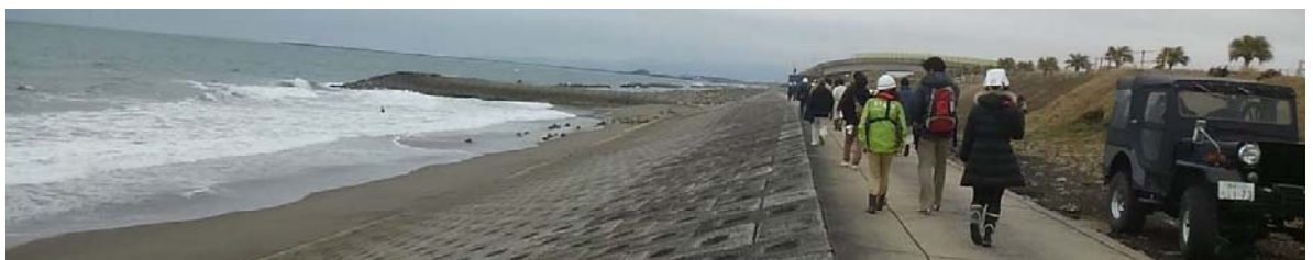
写真 突堤北側の状況（2016(H28)年1月30日撮影）
