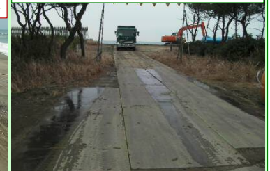
工事用道路設置完了 (H24. 2. 10撮影)
