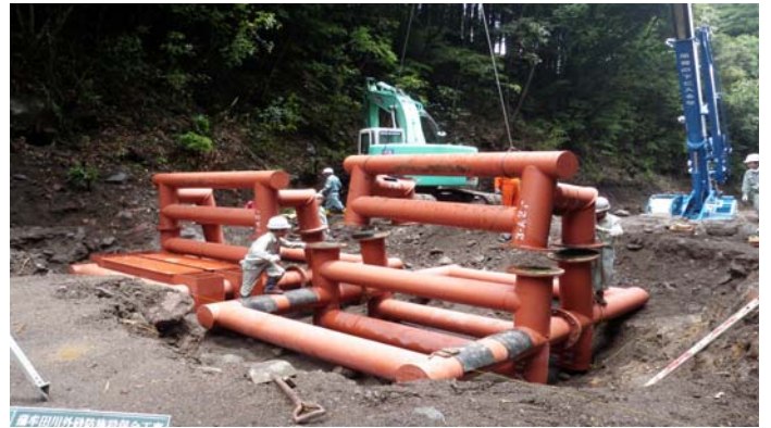
鋼製牛柵設置状況 (設置箇所は砂防ダムより約120m上流)
