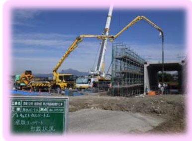
底板コン 打設
