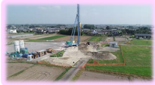
地盤改良工 攪拌
